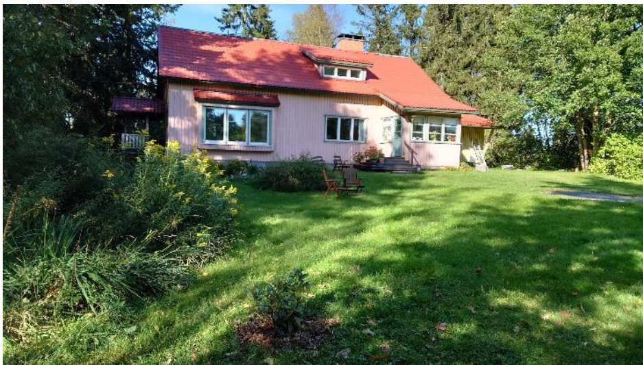
Kuva 10. Partolan nykyinen päärakennus ja pihapiiriä.
