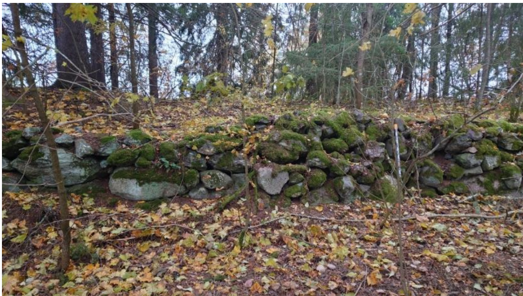
Kuva 22. Kivipengerrys. Kuvattu etelästä.
